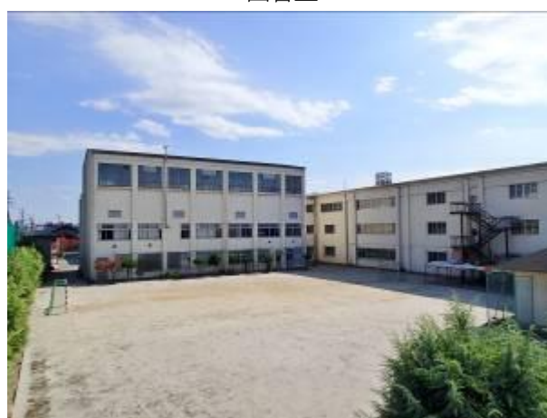
平成25年度に耐震工事が完成しました。
